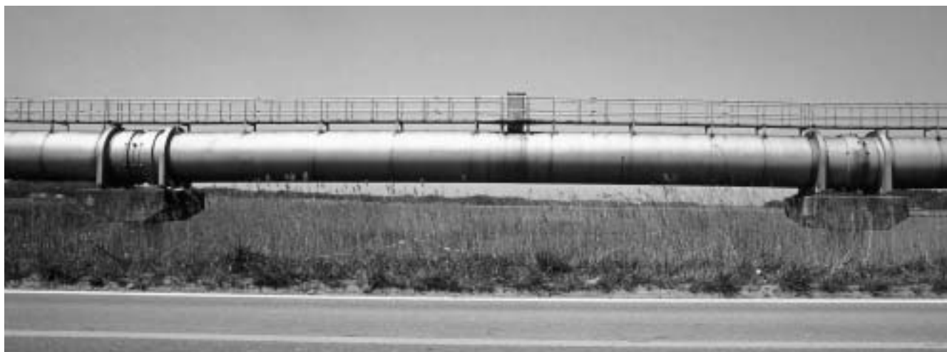
水管橋 伸縮管 (SA型)
