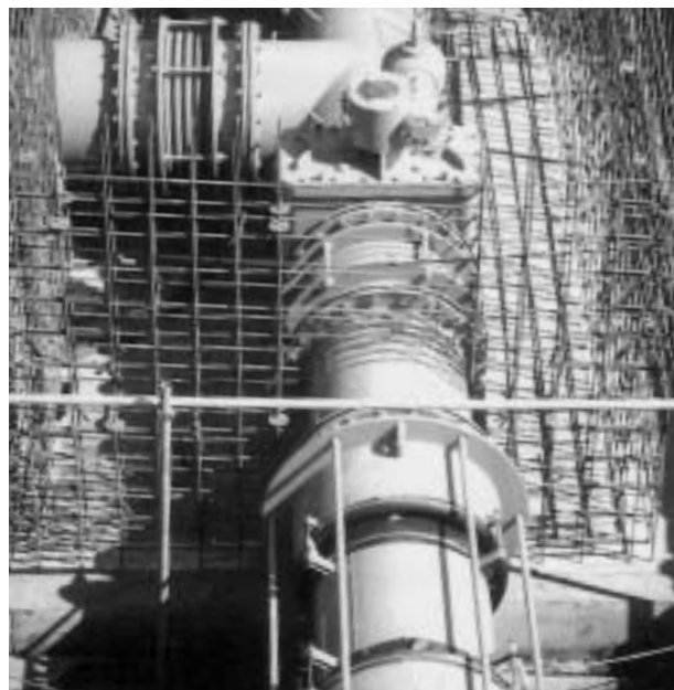
配水場 可撓管 (TLU型) / フランジアダプター (VAL型)
