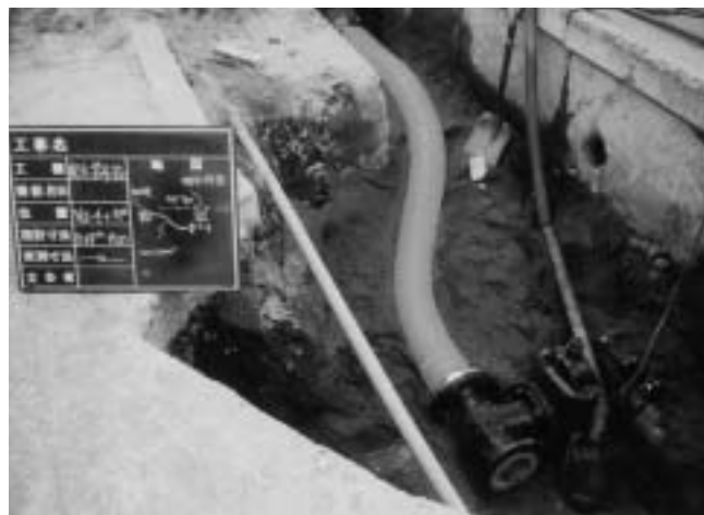
芯ずれの施工例
