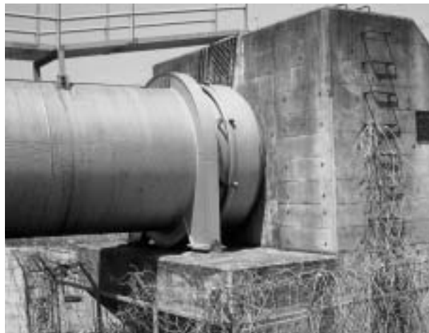
水管橋 伸縮管 (SA型)
